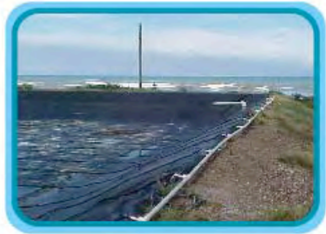
Figura 14 C. Detalle de la tubería distribuidora de aire (Estanque P2.)
