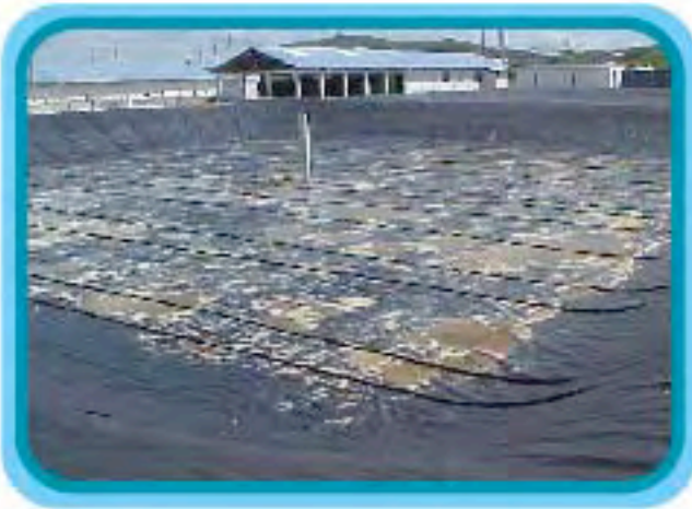
Figura 14 B. Disposición de las mangueras aireadoras en el Estanque P2
